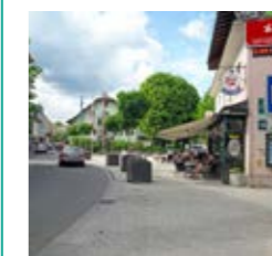
Entlang der Begegnungszone Seekirchen gibt es mehrere Gastgärten und seitlich eine Fußgängerzone. Auf Höhe Hauptstraße 34 befindet sich ein kleiner Platz mit Brunnen und Sitzbänken, welcher mittels Bäumen in Pflanzkübeln abgegrenzt ist
