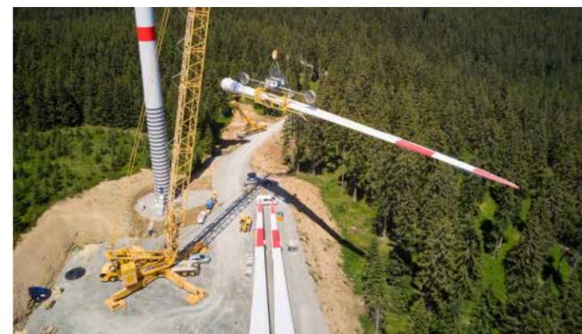
Außergewöhnlich waren bei diesem Einsatz die 62 Meter langen Rotorblätter mit einer Gesamttransportlänge von 72 Metern
